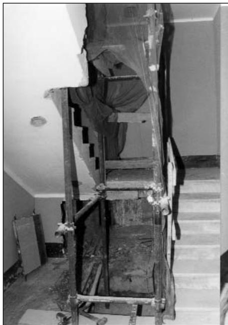
**Foto 2** - Posizionamento del ponteggio
